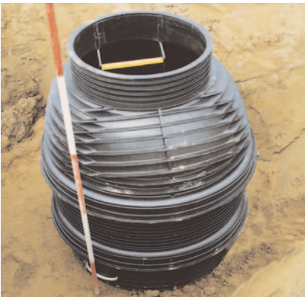
7. Schacht einbetten. Einbettungsmaterial wie Sand, Kies, sandigen Kies oder gebrochenes Material (Größtkorn 20 mm) dabei in gleichmäßigen Lagen einbringen und verdichten. Verdichtung > 97% Proctor
