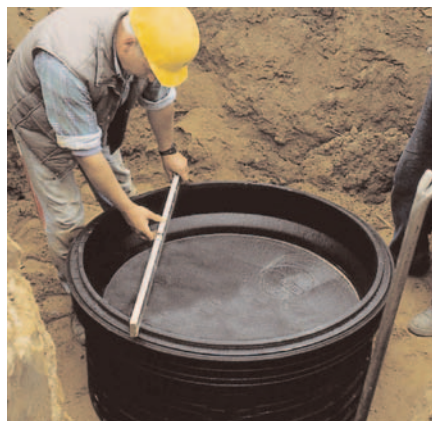
2. Schachtboden entsprechend den Planungsvorgaben ausrichten.
