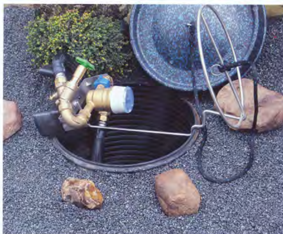
Abb. 2: Wasserzähler-Schachtanlage
