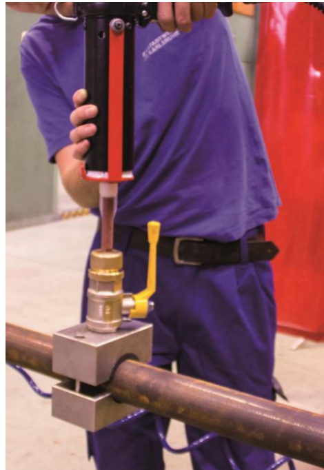
Einbringung des 2K-Absperrschaums in die Anschlussleitung Quelle: Wilhelm Ewe GmbH & Co. KG
