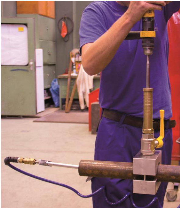
Anbohrung der Stahl-Gasleitung unter Druck Quelle: Wilhelm Ewe GmbH & Co. KG
