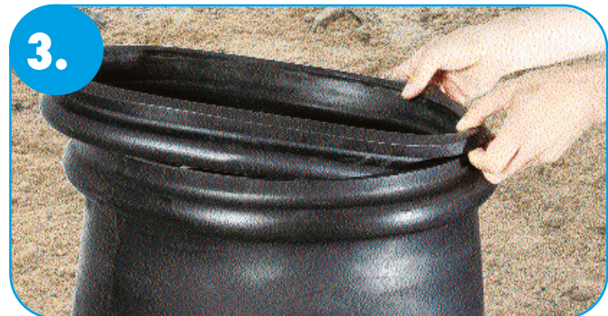
Die Teleskopdichtung wird in den Schachtkörper eingelegt.
