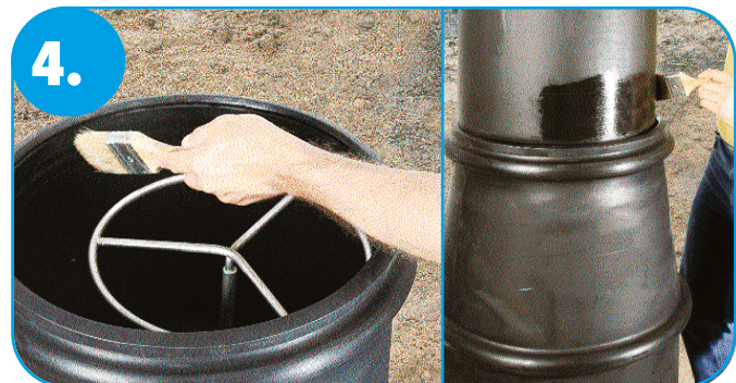
Die Innenseite der Dichtung wird mit Gleitmittel eingestrichen. Der zylindrische Außenbereich wird mit Gleitmittel eingestrichen.
