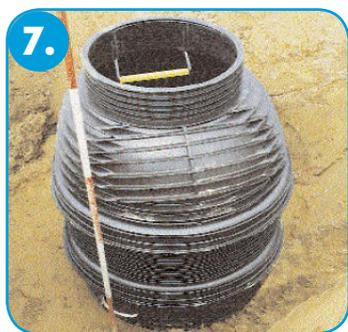
7. Schacht einbetten. Einbettungsmaterial wie Sand, Kies, sandigen Kies oder gebrochenes Material (Größtkorn 20 mm) dabei in gleichmäßigen Lagen einbringen und verdichten.
