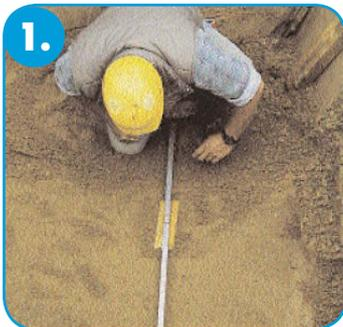
1. Aufstandsbereich des Schachtbodens analog zur DIN EN 1610 vorbereiten, Planum erstellen und Schachtboden positionieren.
