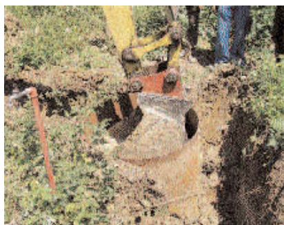
Remplacement d'un ancien regard
