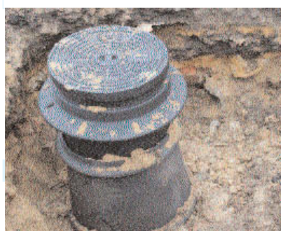
Compactage progressif lors du montage
