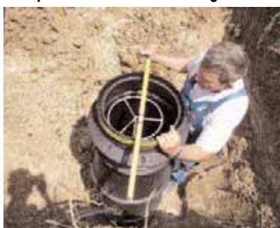
Mise à niveau du regard télescopique EWE
