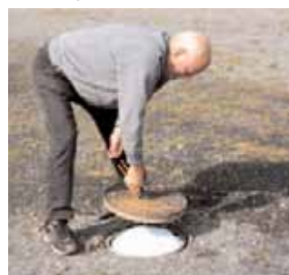
4. Ne pas oublier de mettre en place le coussin isolant avant de refermer le couvercle.
