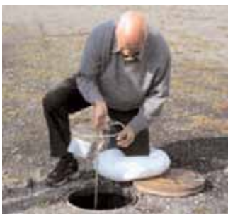
1. Après avoir retiré le couvercle et le tampon isolant, retirez l'installation de compteur en tournant légèrement.
