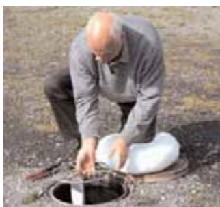
3. En tournant légèrement le volant, l'installation de compteur s'abaisse de nouveau.
