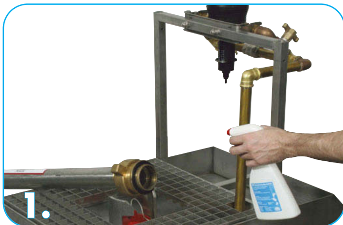
1. Vor Aufbau des Standrohres Dichtung mit geeignetem Mittel reinigen und desinfizieren. (z.B. mit EWE-Armaturen-Desinfekt)
