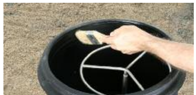
Die Innenseite der Dichtung wird mit Gleitmittel eingestrichen.
