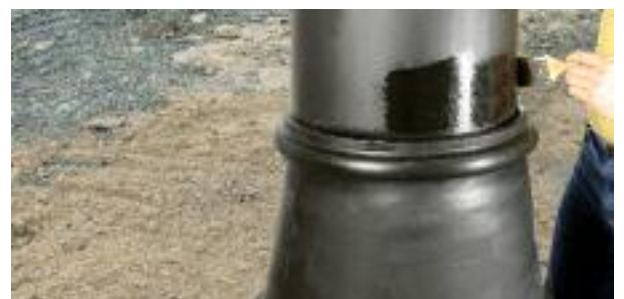
Der zylindrische Außenbereich wird mit Gleitmittel eingestrichen.
