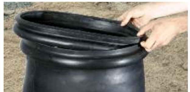
Die Teleskopdichtung wird in den Schachtkörper eingelegt.
